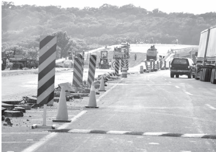
Las obras en la vía federal representan un peligro para el transporte.
