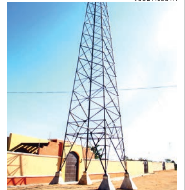
Vivienda bajo inminente riesgo.
